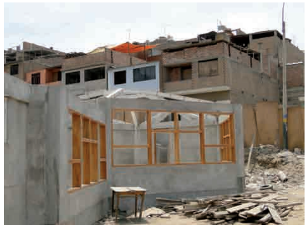
Die 4 Kindergarten-Pavillons im Rohbau
