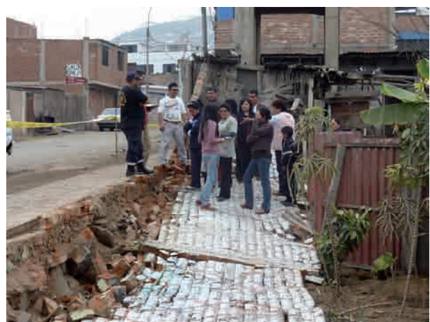
Die kürzlich eingestürzte Aussenmauer macht aufmerksam auf die Baufälligkeit der Schule.
