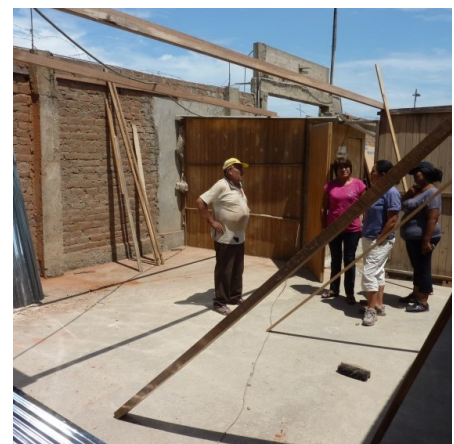
nieuw lokaaltje in aanbouw, Buenos Milagros
